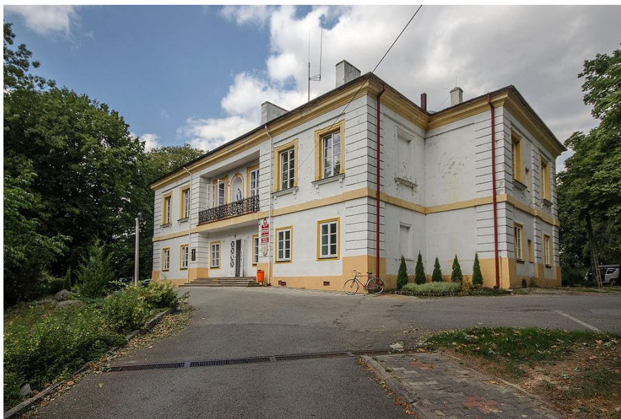
Zdjęcie 3: Pałac w Słupi
